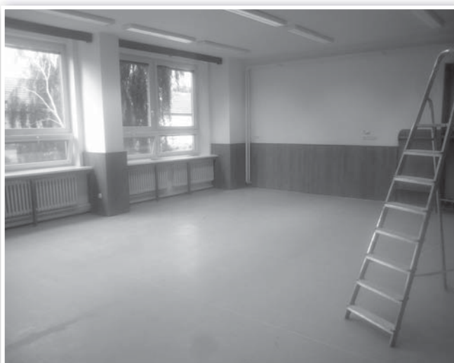
Elektroinstalace přízemí ZŠ a MŠ Suchá Loz včetně nového obložení, vymalování, vybudování nových šaten a oddělení části ZŠ a MŠ
