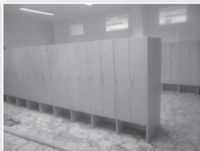
Elektroinstalace přízemí ZŠ a MŠ Suchá Loz včetně nového obložení, vymalování, vybudování nových šaten a oddělení části ZŠ a MŠ
