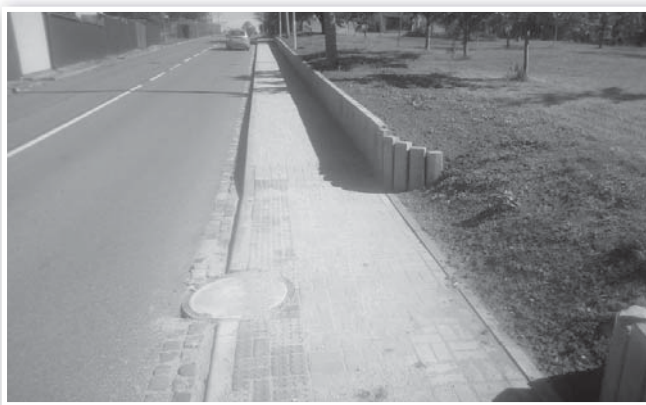
Rekonstrukce chodníků, veřejného osvětlení a vodovodu - II etapa - ulice od Bánova
